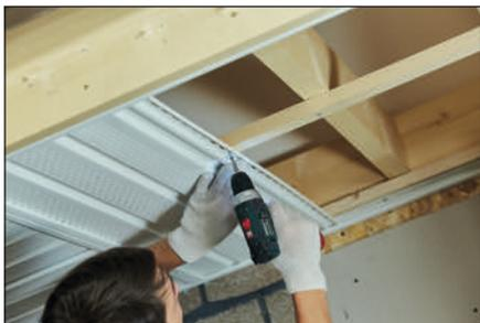
**1.4.** В направляющие профили вставляются в панели и фиксируются при помощи саморезов к обрешетке.
