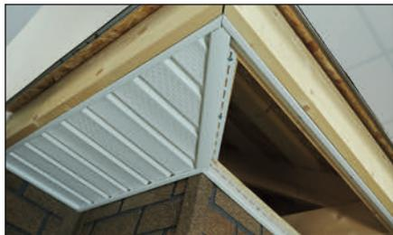
**3.4.** Установка Н-профиля, предназначенного для соединения панелей в угловых зонах. Панели в данном случае подрезаем с учетом этого угла «елочкой». Фиксируем саморезами к обрешетке и стыкуем.
