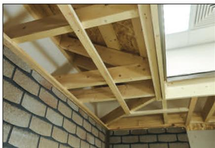
**1.2.** На бруски смонтировать обрешетку. В качестве обрешетки рекомендуется использовать доску 100 × 25 мм. По краям свеса монтируется направляющий профиль (J-профиль).
